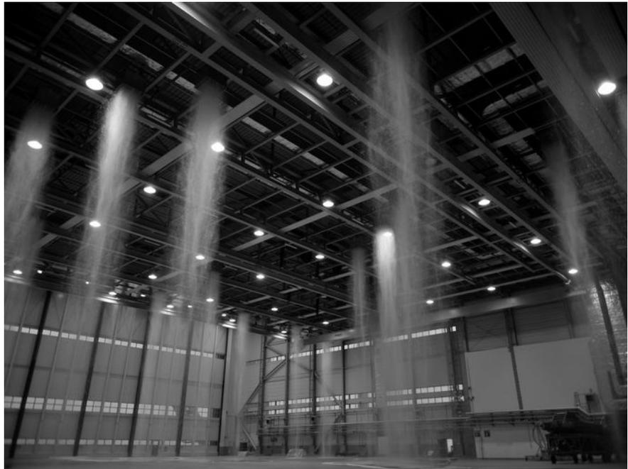
Foto: Flugzeughangar auf der US Air Base Ramstein, der sich mit Löschschaum füllt. In einem unterirdischen Auffangbecken wird der abfließende Löschschaum gesammelt, damit er anschließend in kontrollierten Mengen in eine Kläranlage entsorgt werden kann. Quelle: [www.ramstein.af.mil/News/Photos](http://www.ramstein.af.mil/News/Photos) (Larissa Greatwood)
